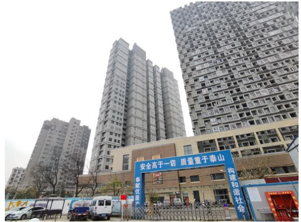
西侧金地阳光小区
