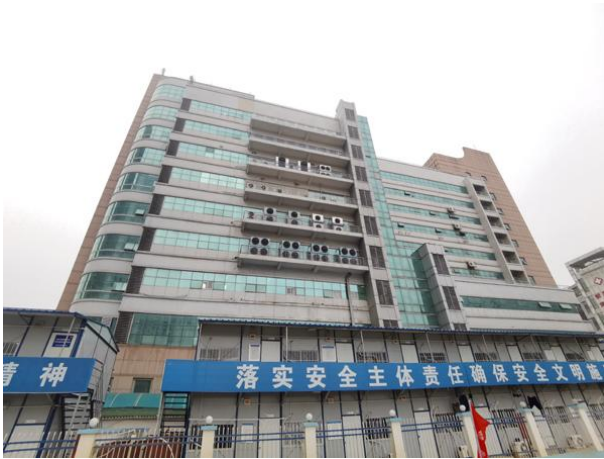
北侧中国移动和邮政局大楼
