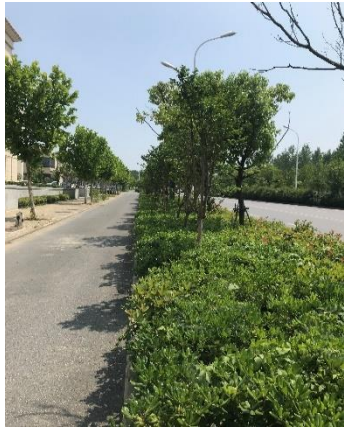
图 8-4 本项目拟建址西侧（吉林路）
