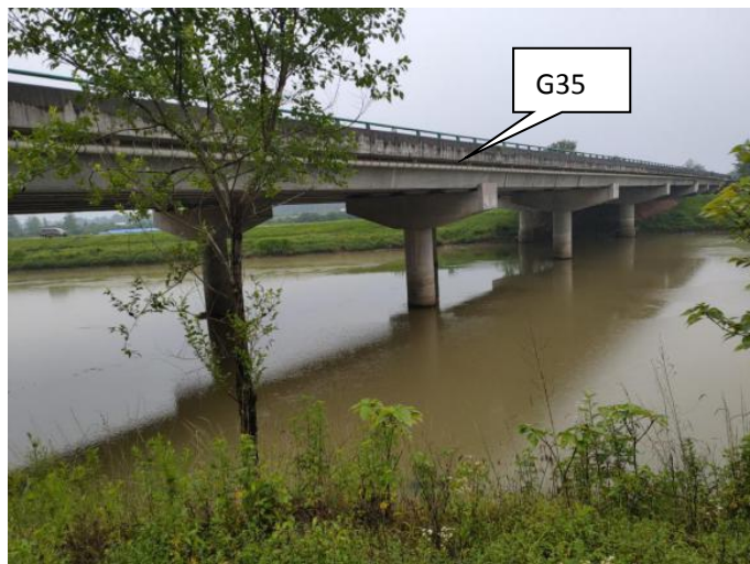
图 2.4-1 六安市淠河总干渠现状照片
