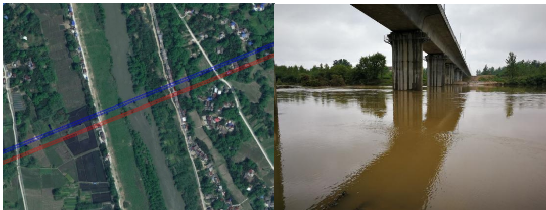
图 2.1-16 皖水特大桥位置及现场照片
