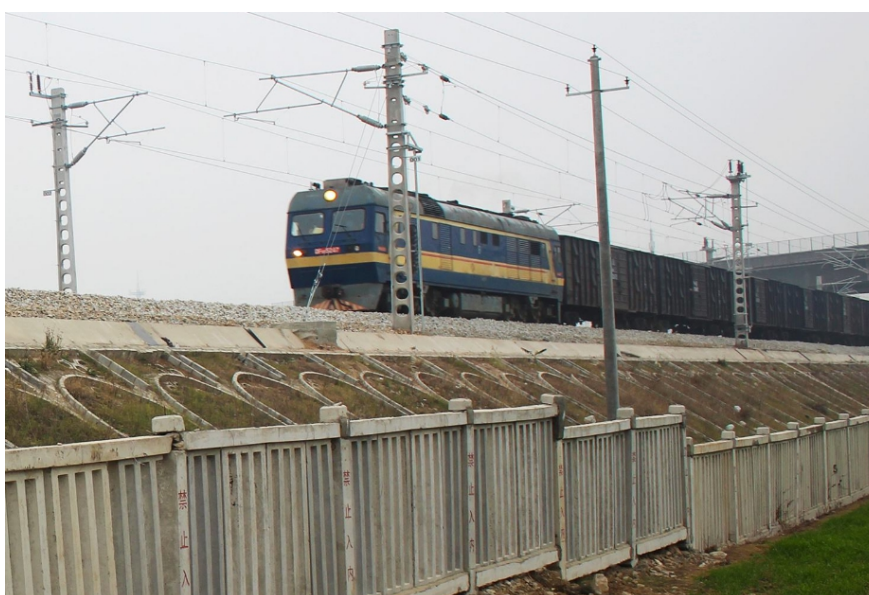
宁西铁路现状照片
