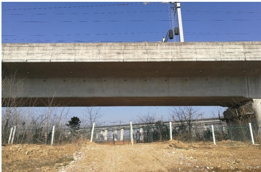
沪蓉铁路现状照片
