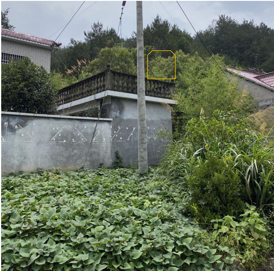
图 2.1-20 平头山隧道口照片
