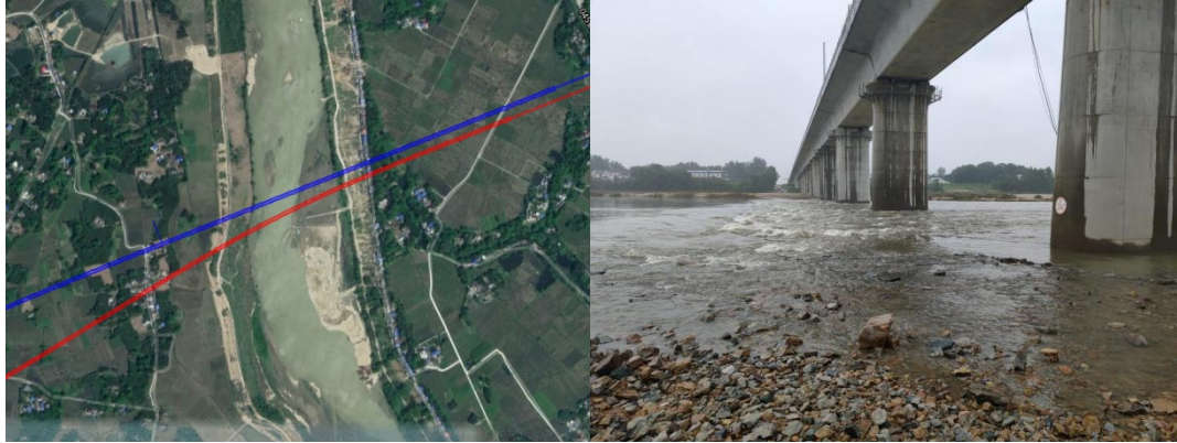
图 2.1-14 潜山特大桥（跨潜水）位置及现场照片
