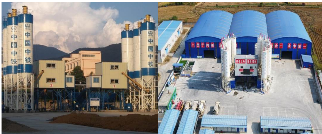
图 4.4-1 混凝土拌合站现场图片
