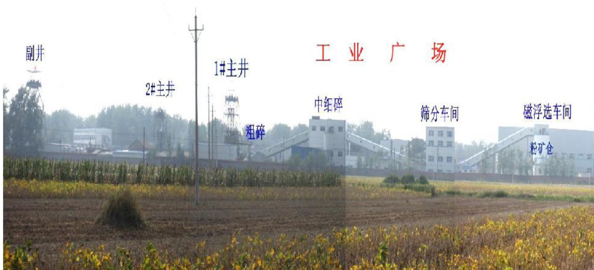
工业广场东侧全景及地貌
