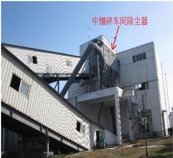
中细碎车间除尘器
