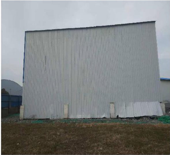
封闭矿石周转场
