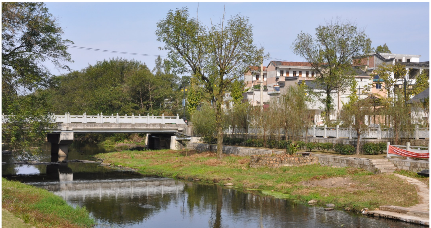
● 经过环境综合治理后,河道的面貌焕然一新。
